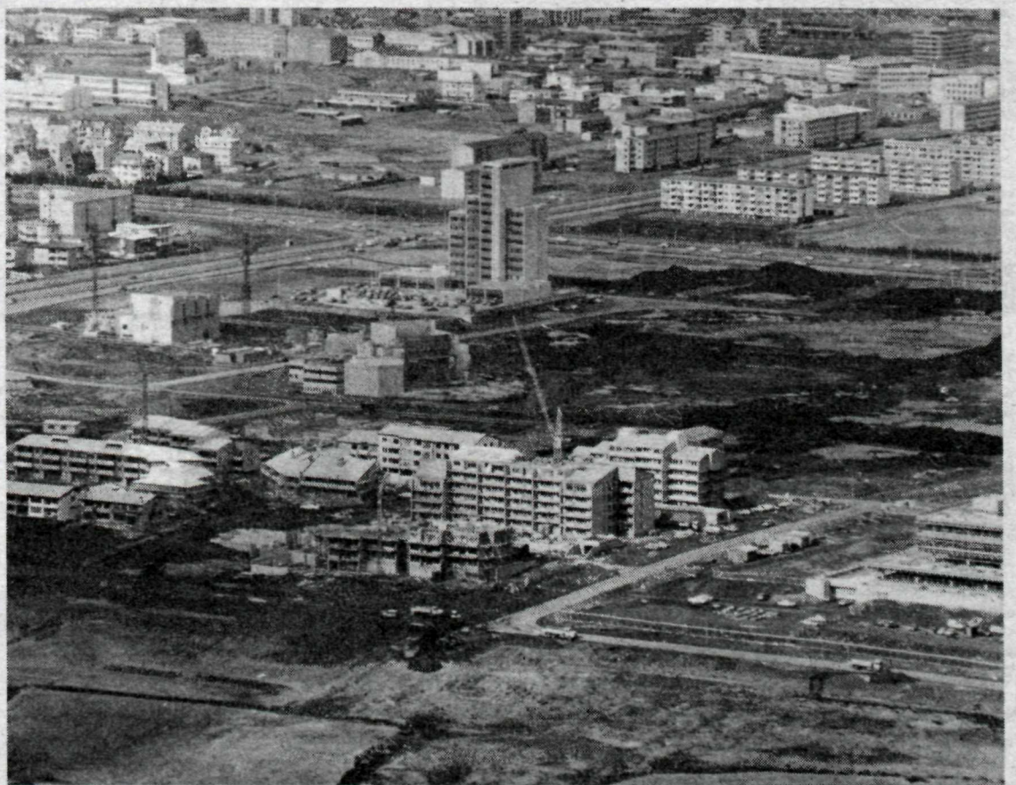
Byggingarframkvæmdir í Nýja miðbænum.
