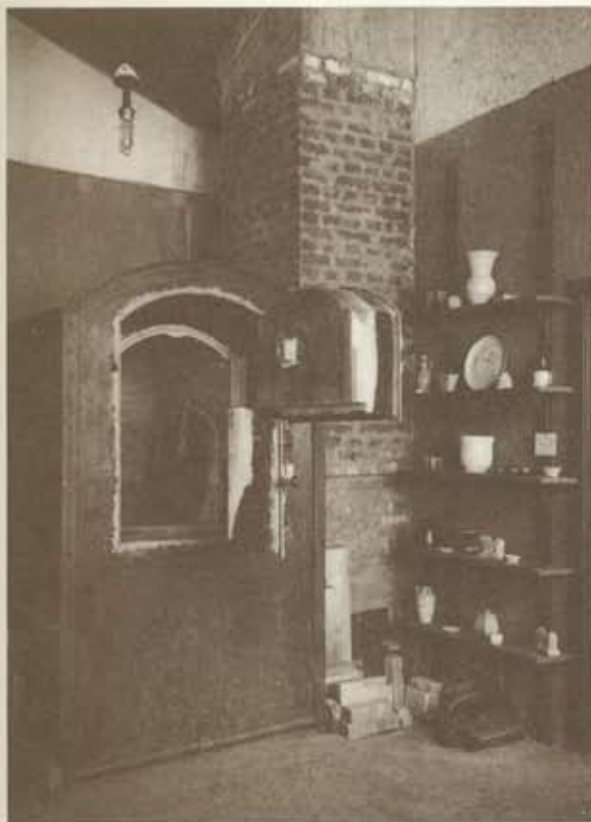
Í Listvínahúsinu: fyrsti leirbrennsluofninn á Íslandi. / In the Friends of the Arts House: the first firing kiln in Iceland.
