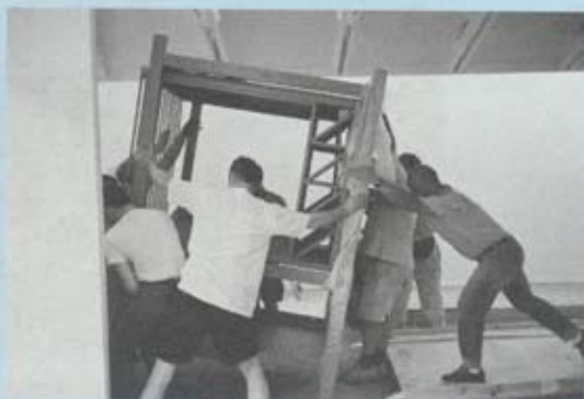
Grindinni af verki Rúríar, Archive – endangered waters komað fyrir í Alvar Aalto-skólanum á Feneyjahlaeringnum 2003/During the installation of the structure for the work Archive – endangered waters by Rúrí, in Alvar Aalto pavilion at the Venice Biennale 2003. Með leyfi Lauleyjar Helgadóttur/Courtesy of Lauley Helgadóttur.
